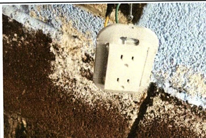
Foto 4: instalación de tomacorrientes de aulas.
