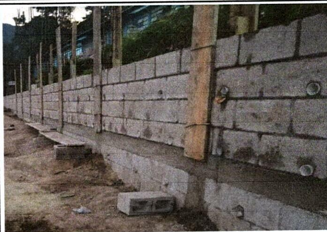
Foto 2: formaleta de columnas.
