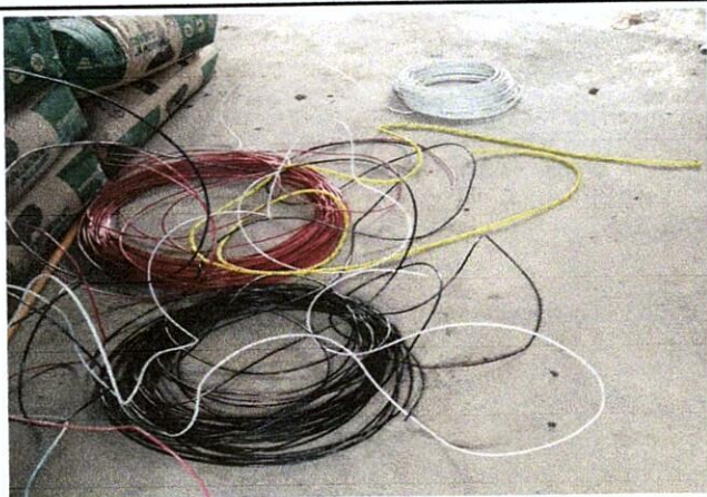
Foto 3: cableado de mejoramiento del sistema eléctrico en aulas.
