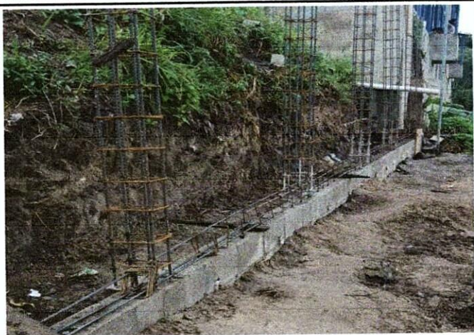
Foto 1: armando solera de mejoramiento de muro perimetral.
